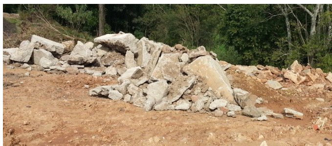
Figura 68 - Resíduo oriundo da construção civil sendo utilizado em aterro de propriedade privada
