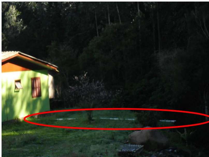
Figura 47 - Tubulação ligada diretamente a arroio.
