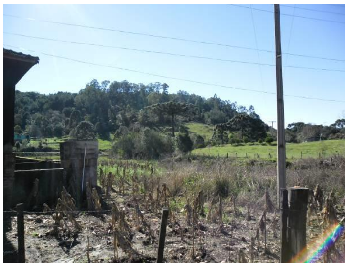
Figura 46 - Local de instalação da ETE
