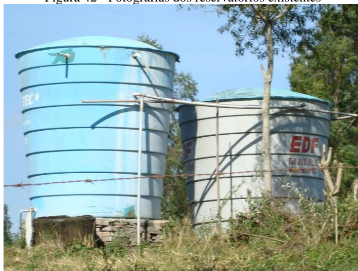
Figura 42 - Fotografias dos reservatórios existentes
